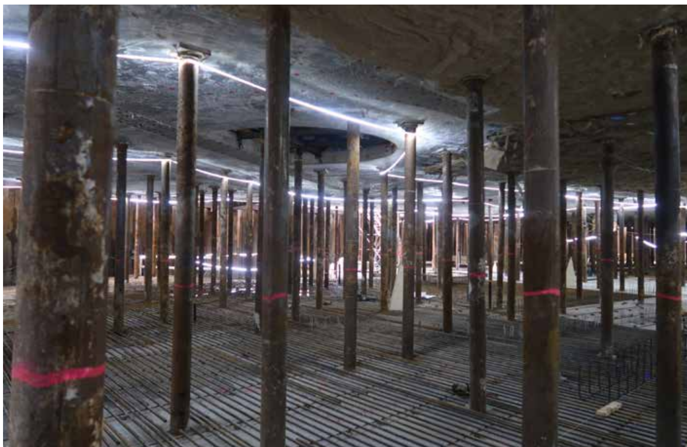
Met de PileCore-applicatie van CEMS kan een complex palenplan automatisch worden geoptimaliseerd. (Fotografie: David Hartmann)
